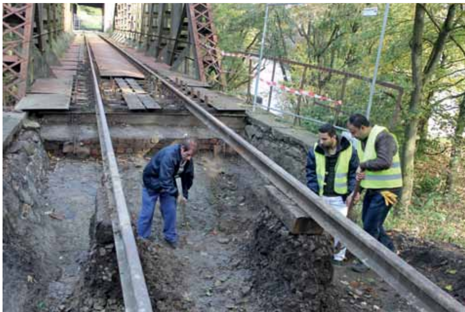
Rund 1.000 arbeitslose Menschen haben bisher insgesamt am Projekt Nordbahntrasse teilgenommen.
